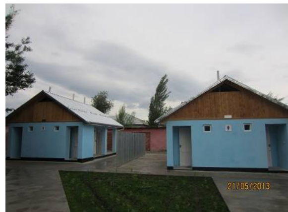
写真6：本件で建設された男女別トイレ
