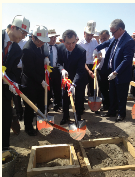
Торжественная закладка бетона
